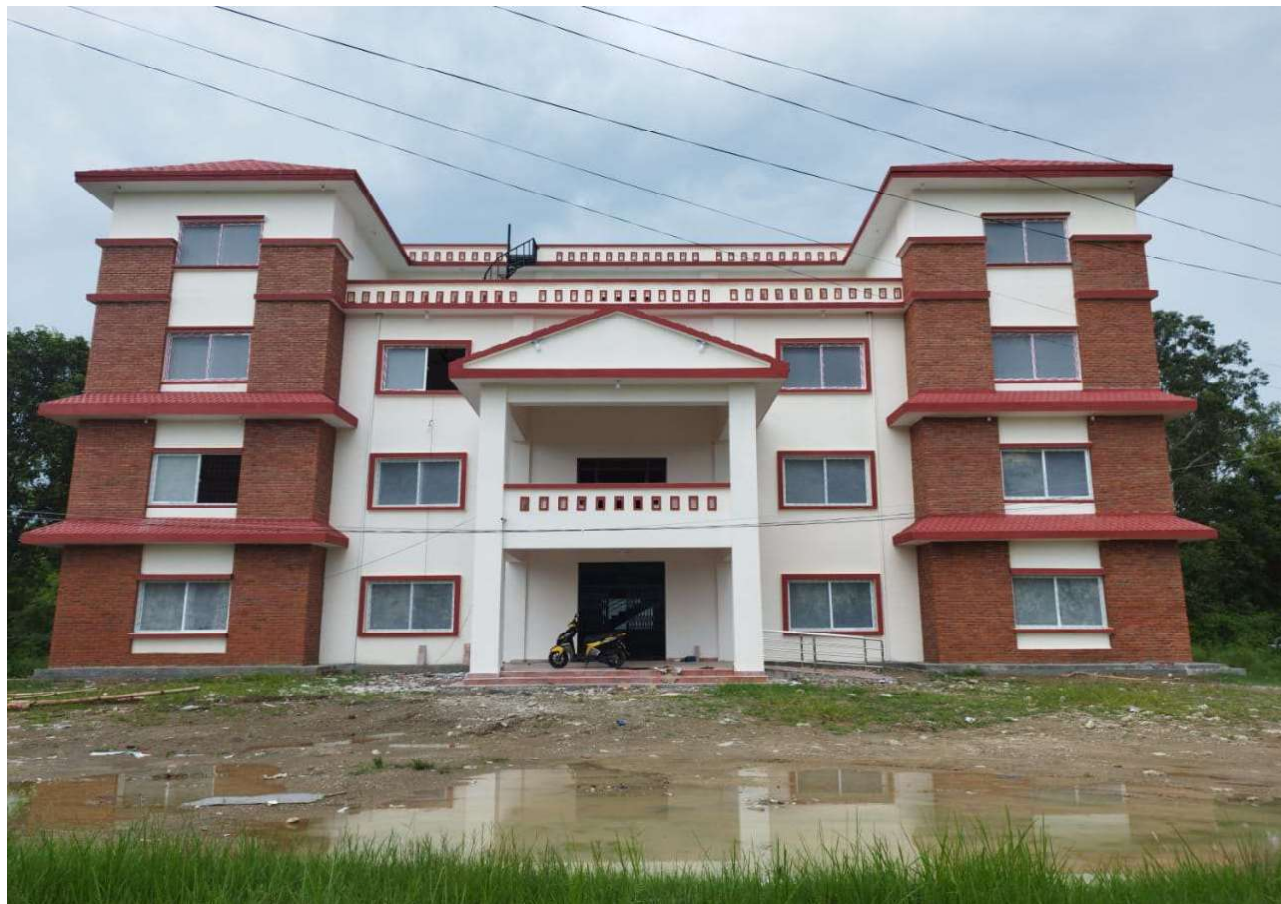
तस्विर: दंगीशरण गाउँपालिकाको निर्माणाधिक प्रशासकीय भवन
